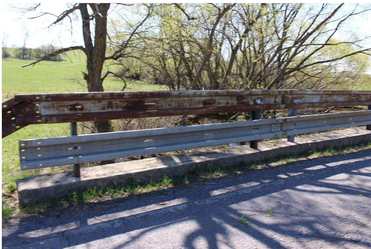
Obr. Nepredpisové zvodidlo
