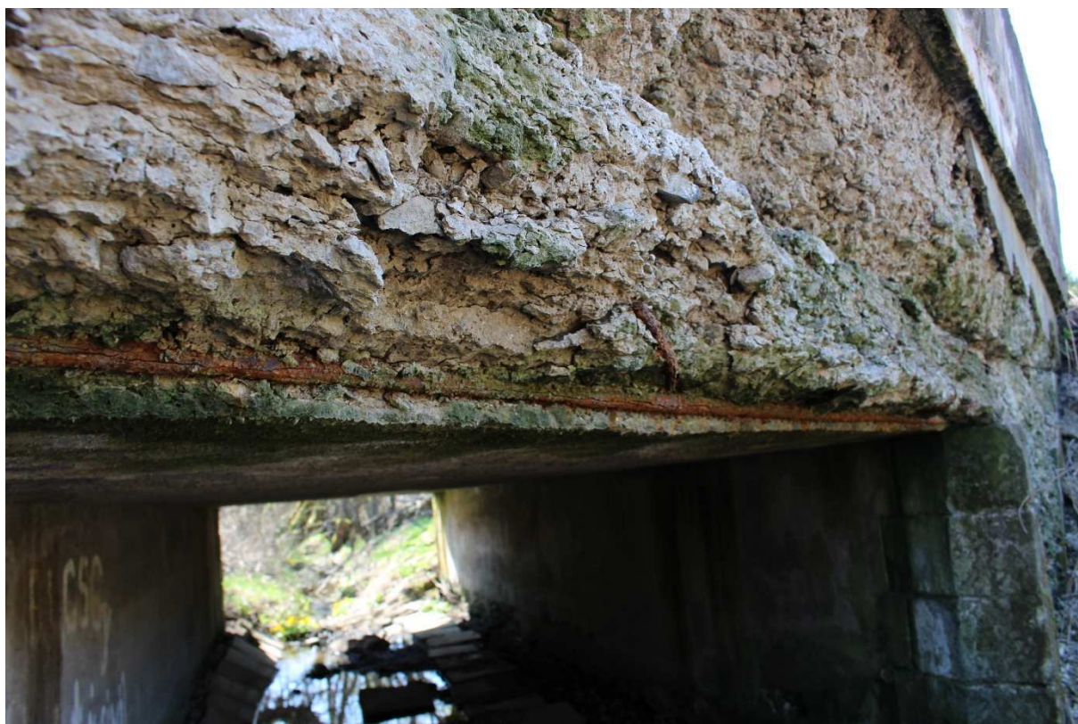
Obr. Degradácia betónu nosnej konštrukcie
